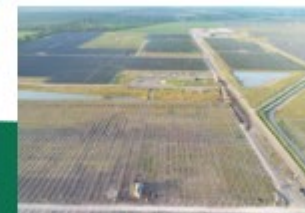
Rayos del Sol Solar Farm, TX
